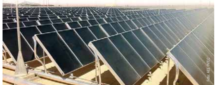
In der saudi-arabischen Hauptstadt Riad hat Ende 2011 das Kärntner Unternehmen GREENoneTEC die weltgrößte Solaranlage zur Warmwasseraufbereitung - eine Anlage mit 36.305 m 2 Sonnenkollektoren und einem Wert von 3,6 Mio Euro - errichtet, das steirische Forschungsinstitut AEE Intec fungierte als technischer Berater für den Generalunternehmer.
